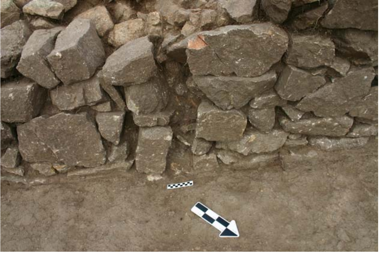
Şekil 97. İkinci Oda'nın batı duvarının yüzünde yer alan dar dikme yuvası. (11dpcc0524)
