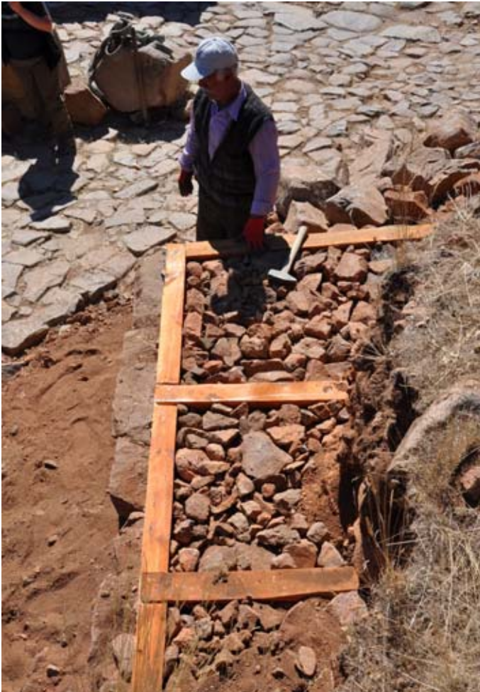
Şekil 76. Hatılların arası moloz taşlarla dolduruldu. (11dpnd2356)
