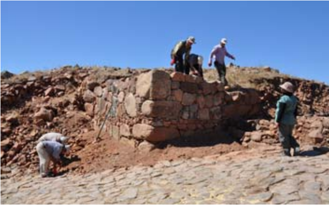
Şekil 79. Batı Kule onarım aşamasında. (11dpnd2434)
