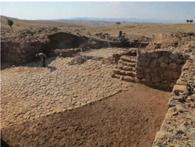
Şekil 80. Geniş taş döşemenin, Batı ve Doğu Kulelerin onarımından sonraki nihai temizlik çalışmasının son aşaması. (11dpcg3029)
