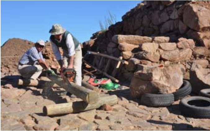
Şekil 75. Artık kullanılmayan telefon direkleri restorasyonu yapılan duvara yerleştirilmeden önce köşeli hale getirildi. (11dpnd2356)
