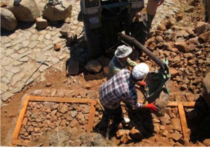
Şekil 77. Büyük taşlar traktörün hidrolik sistemi yardımıyla kaldırıldı. (11dpnd2434)
