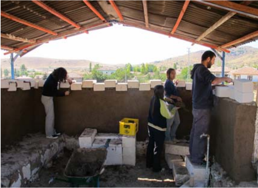
Şekil 22. Mimarlık öğrencileri, inşa ettikleri deneysel binada geleneksel ve modern malzemeleri bir araya getirmekteler. Gazbeton (AAC) tuğlalar, AKG Gazbeton tarafından bağışlanmıştır. (11kecg1318)
